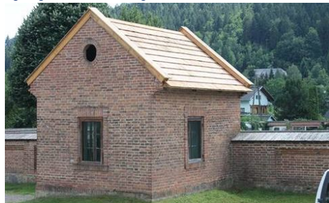
Alter Karner beim Friedhof mit Lärchenbrettern neu eingedeckt.
