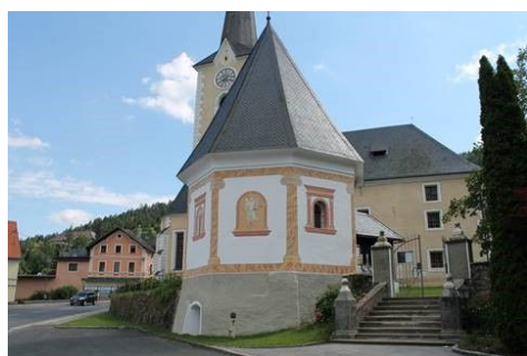
Aussenfassade vom Karner generalsaniert. Dank an die Gemeinde Himmelberg für die Durchführung.
