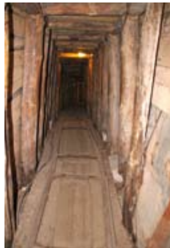
Der Flucht- und Versorgungstunnel
