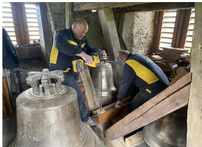
Viele Stunden wurde im Kirchturm gearbeitet
