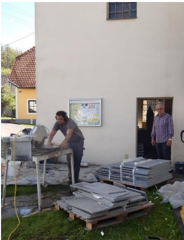
Vorbereiten der Bodenplatten
