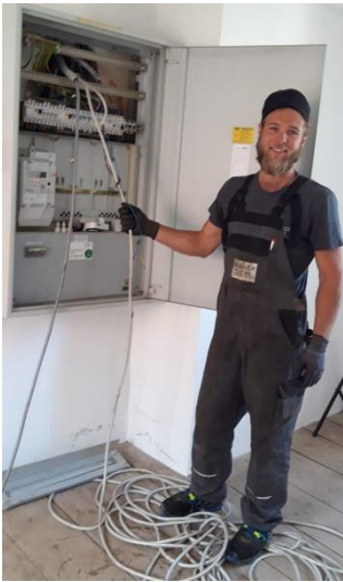
Monteur bei Verlegung der Verbindungsleitung
