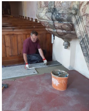
Beginn der Bodenverlegung
