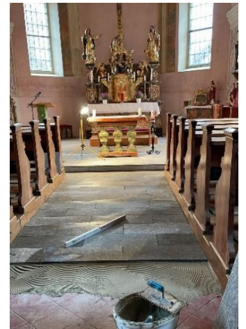
Mittelgang in Arbeit
