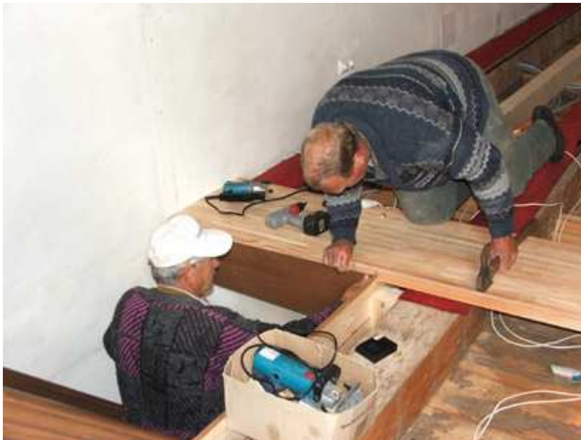
Nach dem Herausreißen des alten Bodens wird nun ein neuer Boden von den fleißigen Helfern Pfeifhofer Siegfried, Brunner Siegbert und Palle Georg montiert.
