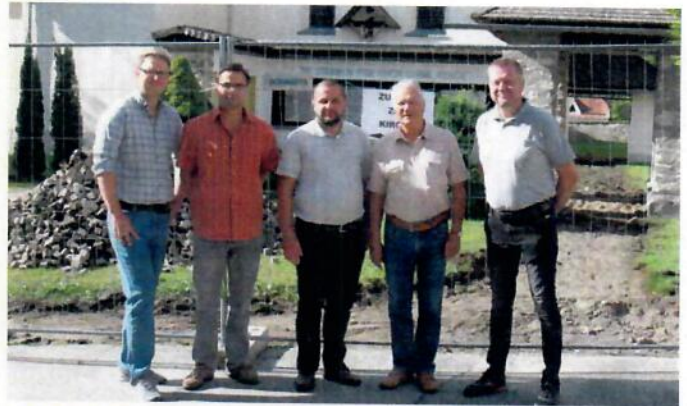
Baustellenbesichtigung am 30. Juni 2017 durch Vertreter der Gemeinde und Pfarre: AL DI Gerd Sarnitz, Diakon Michael Ebner, Prov. Marcin Mrawczynski, Bgm. Hans Ferlitsch und Ing. Harald Madritsch.
