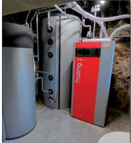
Neue Heizung im Pfarrhof
