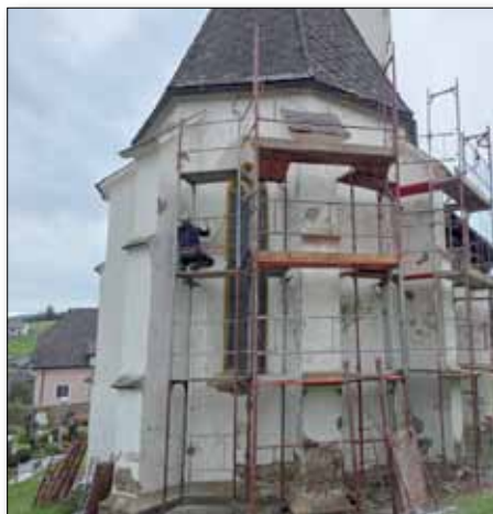
Renovierungsarbeiten an der Pfarrkirche ab 21.9.2026
