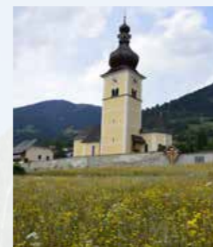
Die Friedhofswiese in Obermillstatt ist auch eine Bienen-tankstelle geworden
