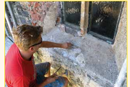
Freilegung einer desolaten Fensterbank
