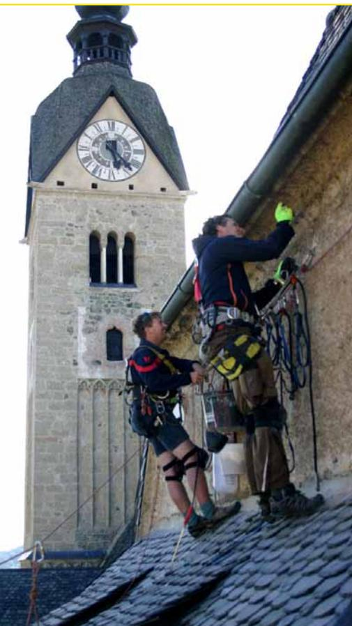
*Risskittungen an der Querhauswand
