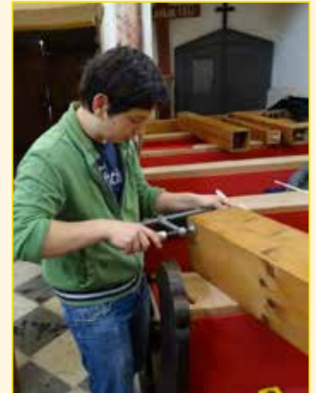
Reparaturarbeiten bei erkannten Schäden
