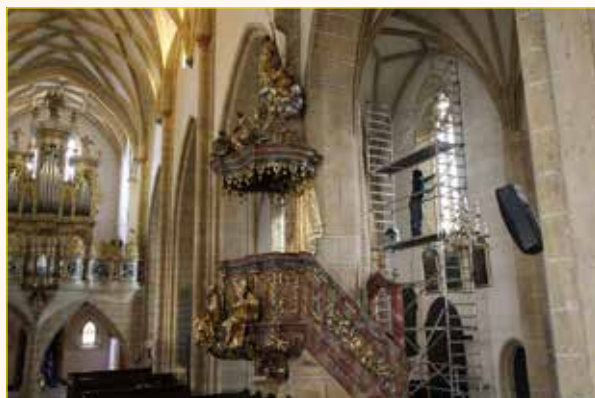
Detailansicht vor und nach der Reinigung
