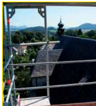
Das Arbeiten in schwindelnder Höhe war am Anfang eine Herausforderung
