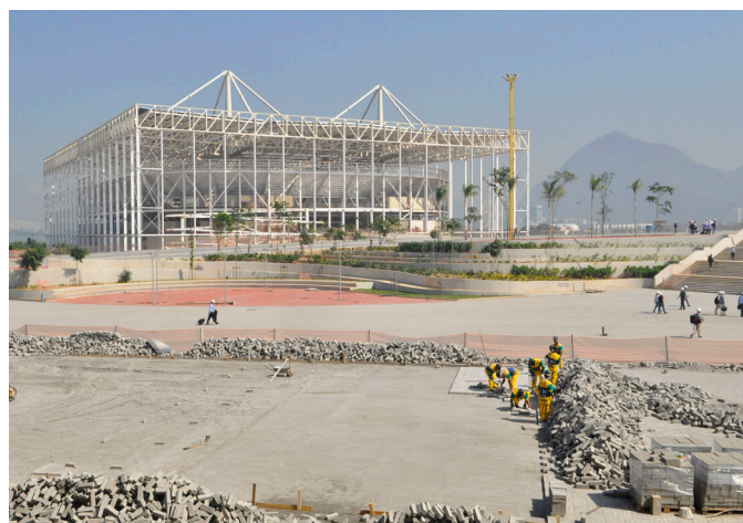
Eine der größten Baustellen ist der Olympia-Park im Stadtteil Barra, gleich neben der Vila Autódromo
