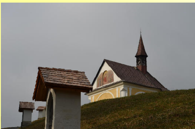
Die Pfarre St. Stefan organisierte 2014 die Restaurierung der Kreuzwegstationen. Die Gemeinde besorgte 2015 die Renovierung der Außenfassade der Kalvarienbergkirche.
