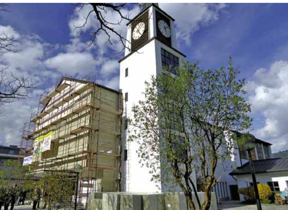
Thermische Außensanierung der Kirche Schüttdorf
