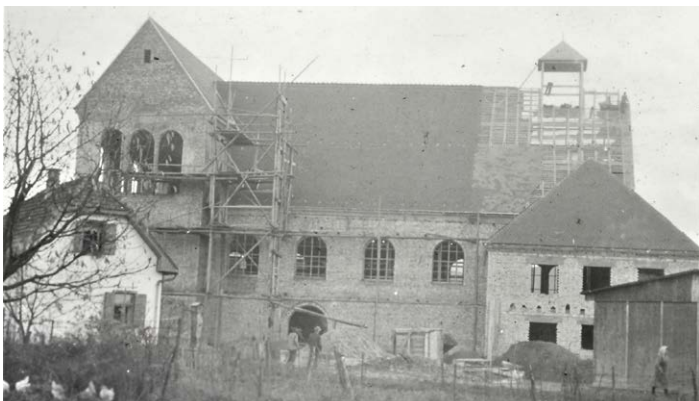
Rohbau der Pfarrkirche St. Josef – 1951
