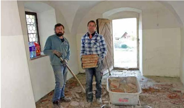
Beim Sanierungsprojekt der Filialkirche St. Gandolf ist die erste große Etappe bereits zur Gänze geschafft: Die frühbarocken Fenster sind saniert, der Ziegelboden ausgebessert und erneuert, der Strom eingeleitet und die Vordächer zu den Eingängen errichtet; darüber hinaus wurden die ersten Arbeiten zur Elektrifizierung geleistet und die Wände innen saniert.
