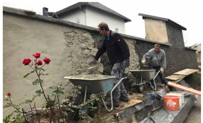
**Die untere Mauer beim Pfarrhofgrundstück** wurde durch die Baufirma Begusch saniert. Die Wasserschäden machten die Sanierung notwendig. Bei dieser Gelegenheit wurde auch ein Versickerungsschacht gegraben.
