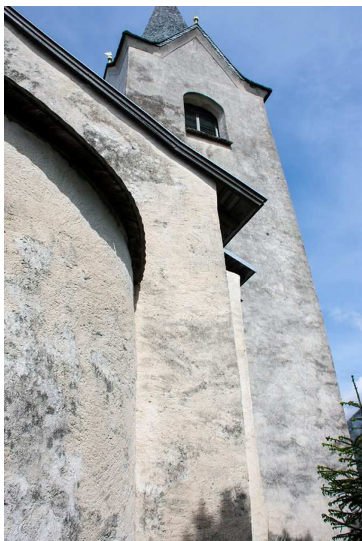
Bild vor der Sanierung
