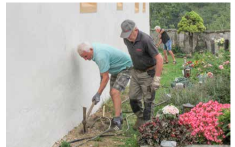
Die fleißigen freiwilligen Helfer beim Verlegen des Erdkabels
