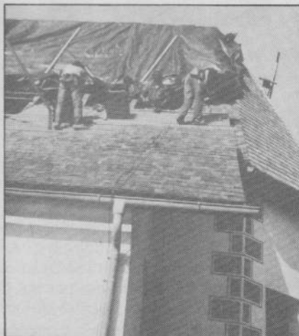
Marljivi delavci tesarskega podjetja Gasser pri delu na strehi velinjske podružne cerkve. Popravilo strehe je stalo več kot 300.000 šil.
